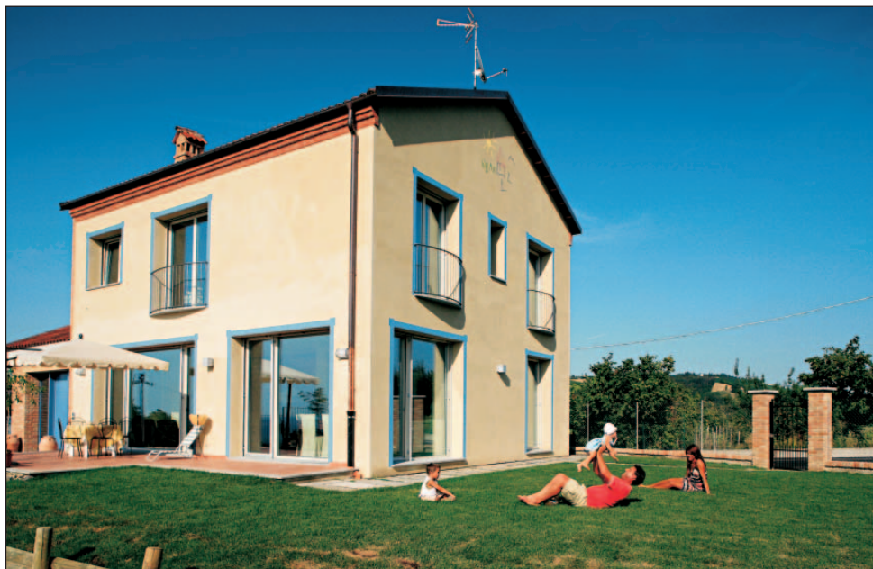
Vista da sud dell'abitazione unifamiliare a Cherasco (Cuneo)
